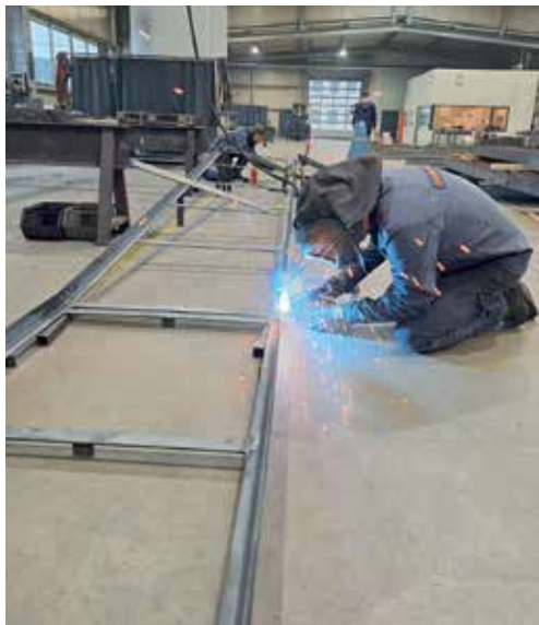
Jens Rockstroh bei Schweißarbeiten
